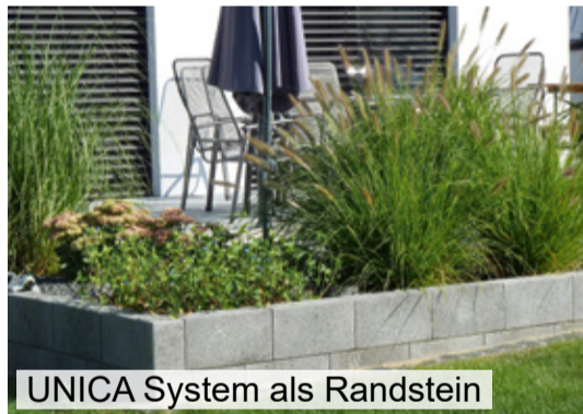
UNICA System als Randstein: links überstehend, rechts bodengleich als Übergang zum Haus bzw. Eingang
